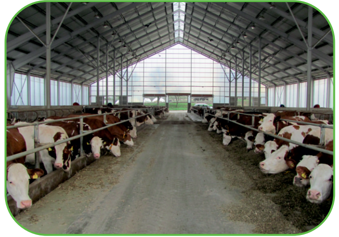
vysoká a vzdušná konstrukce stáji
