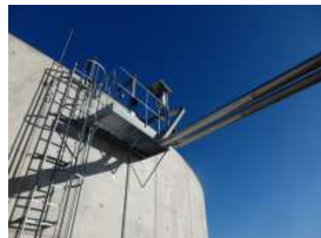
Plošina pro obsluhu míchadel.
