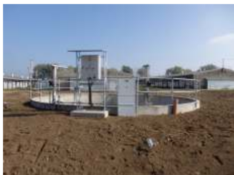
Ovládací panel u čerpací jímky.
