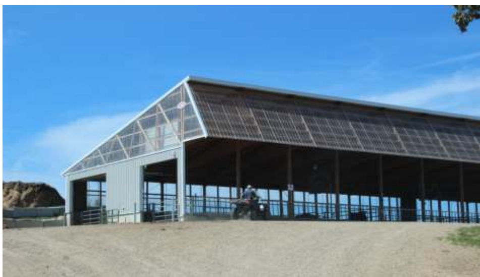
obr. 2) Stáj s otevřeným krmným stolem a tubusovou ventilací.
