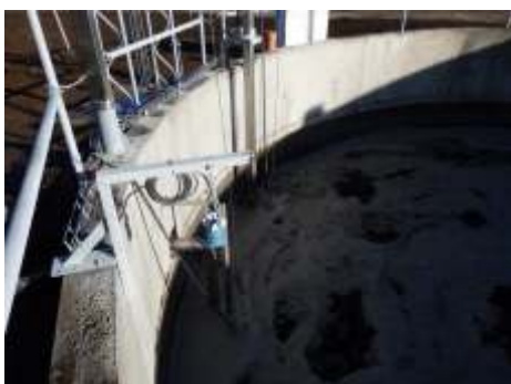
Ultrazvukové čidlo snímání hladiny.
