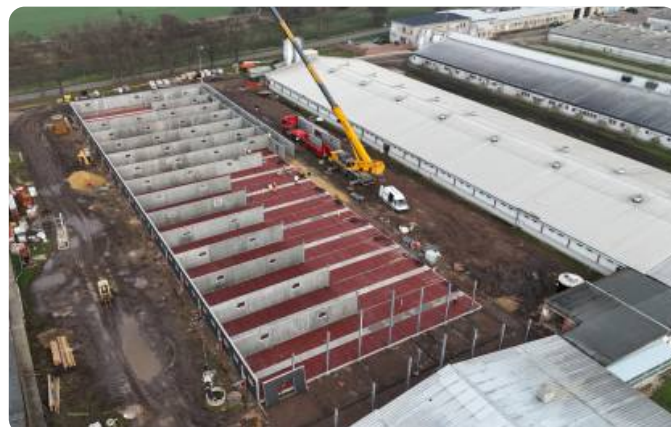
Probíhající výstavba porodny v Lišanech
