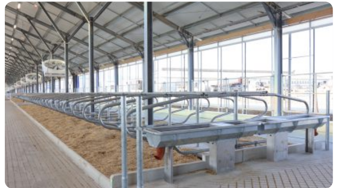
Nad zastýlanými boxy jsou žaluziové ventilátory VHV
