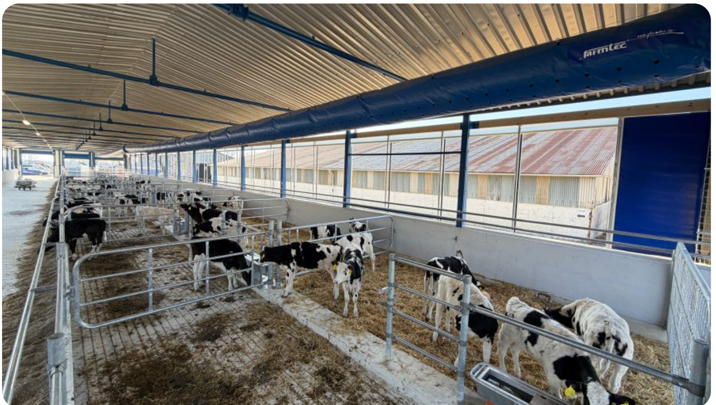
Nová je také stáj pro odchov telat s tubusovou ventilací.
