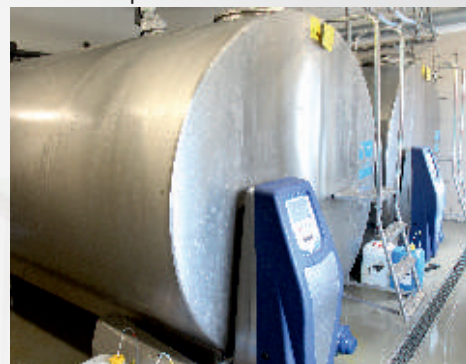
Silo a tanky SERAP pro chlazení a skladování mléka
