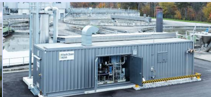
Ilustrační foto, zdroj Hitachi. Kontejnerové membránové čištění bioplynu.
