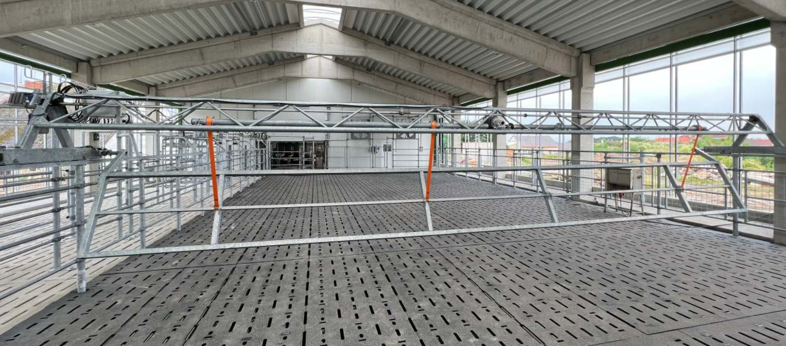
Vzdušná a otevřená čekárna dojnic s přiháněčem FARMTEC má celoroštovou podlahu a povrch roštů je pokryt gumami Kraiburg.
