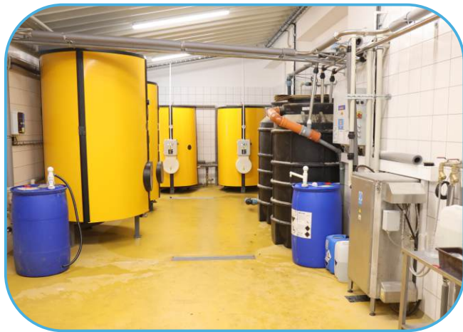
technické zázemí dojírny, zásobníky vody, rekuperace tepla
