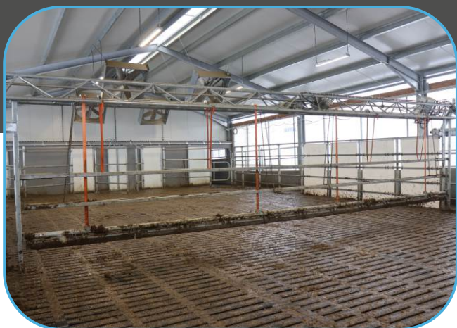
zarošťovaná čekárna s přiháněčem se shrnováním kejdy
