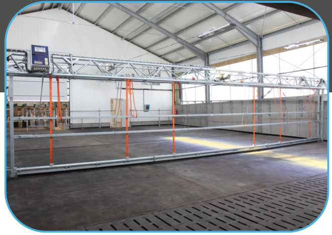
čekárna dojnic s přiháněčem se shrnováním kejdy
