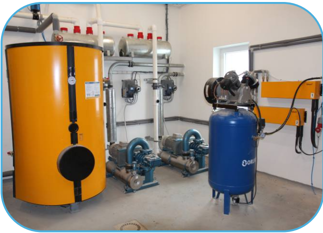
dmychadla s frekvenčními měniči
