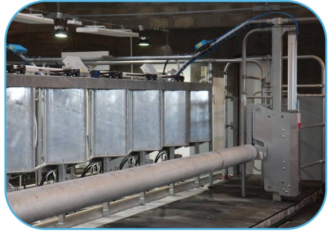
nová konstrukce rychlého odchodu dojnic
