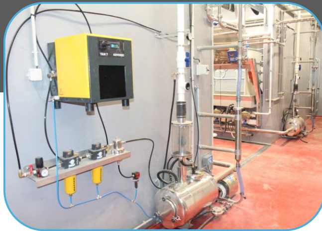
každá polovina dojírny je samostatně funkční
