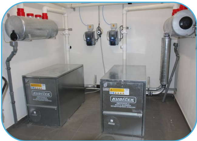
dmychadla s frekvenčními měniči otáček
