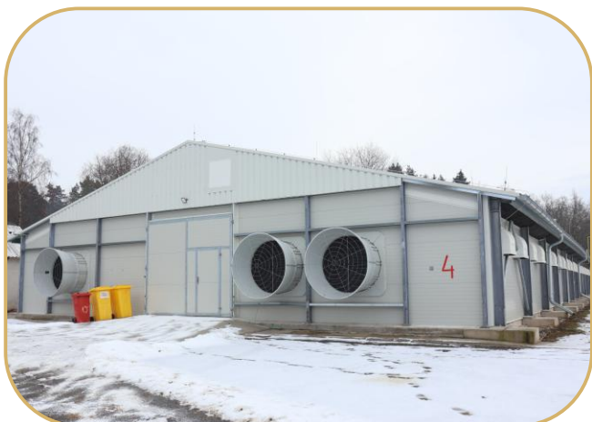
štítové ventilátory a stěnové přívodní klapky na hale č. 4
