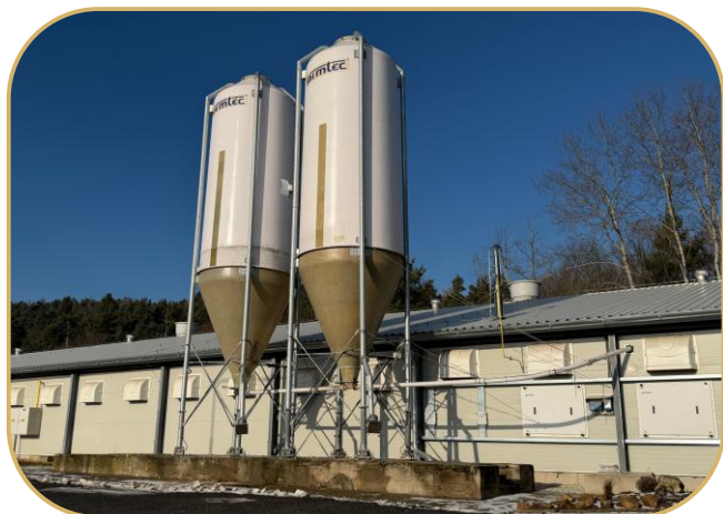
sklolaminátová sila vč. tenzometrů a váhového modulu
