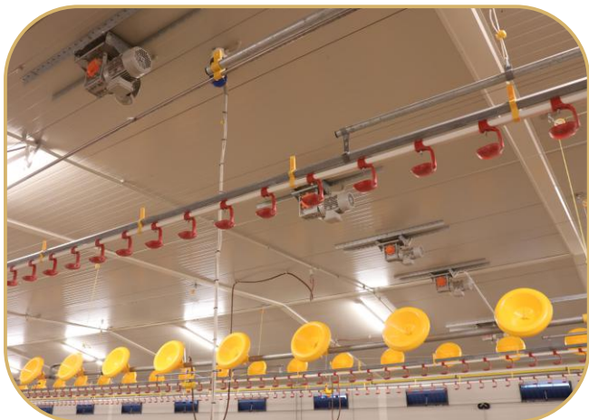
el. zvedané krmné a napájecí linky s celonerezovými nipyly
