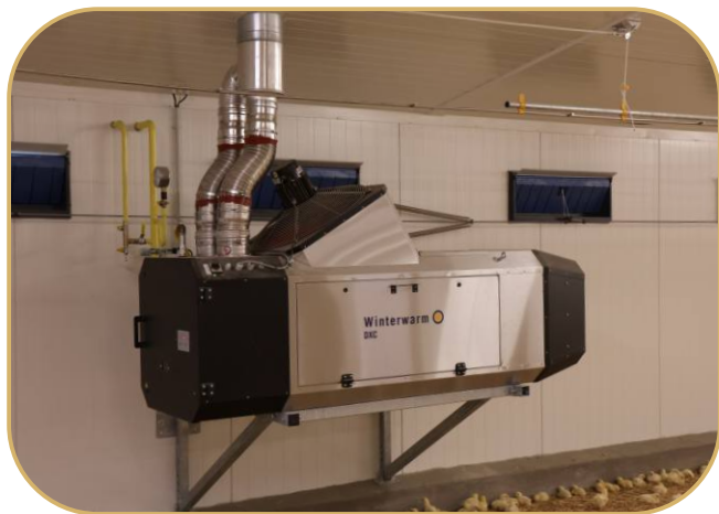
plynové topidlo DXC s nepřímým spalováním WinterWarm
