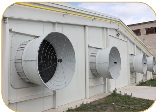
ventilátory v zadním štítu haly
