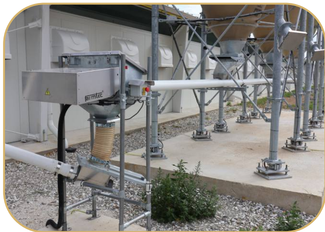
sklolaminátová síla s tenzometry vč. přesypového místa
