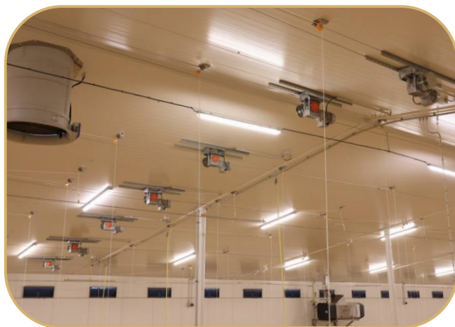
odtahové komíny a elektrické navijáky pro zvedání linek
