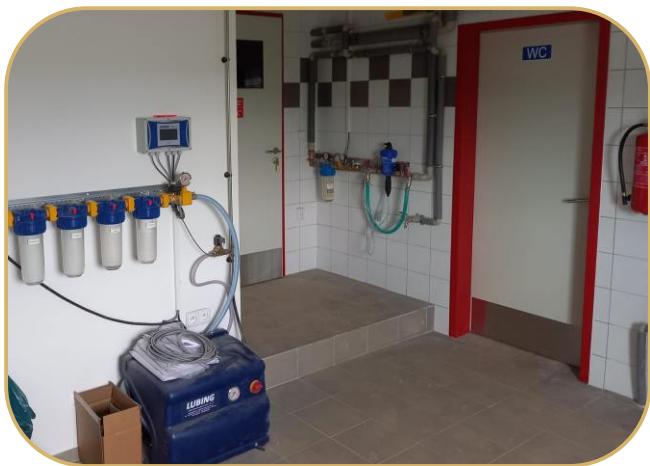
uzel s medikátorem pro systém napájení
