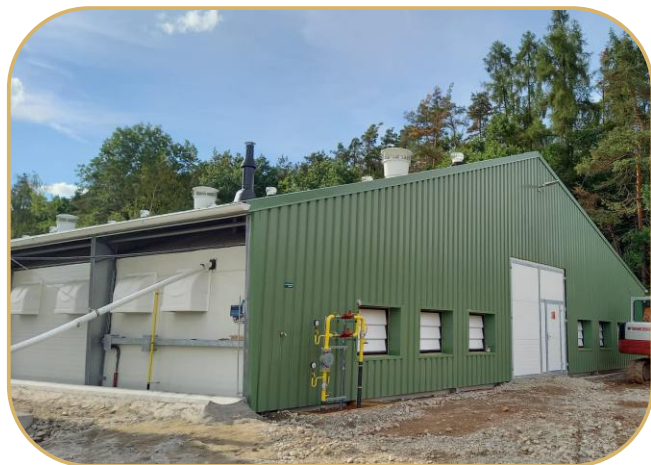
stěnové a tunelové přívodní klapky
