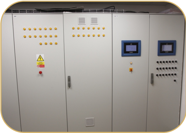
systém řízení klimatu s využitím vzdálené správy
