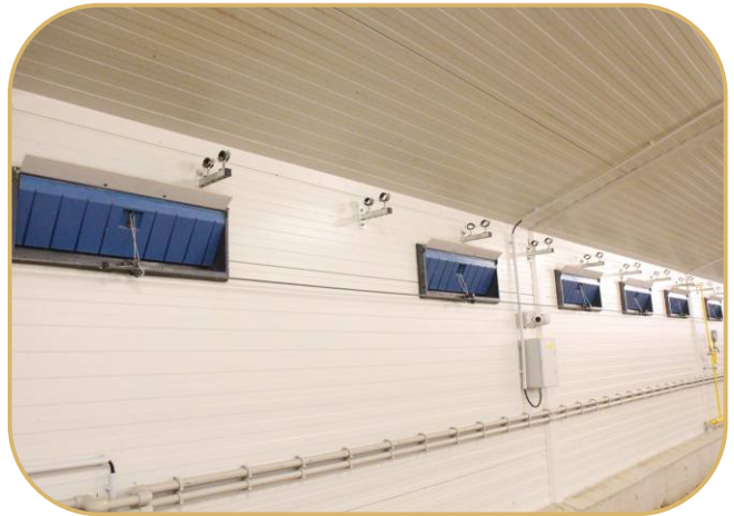
stěnové přívodní klapky
