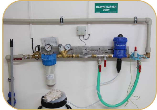
uzel s medikátorem pro systém napájení
