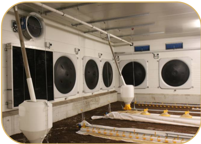
stěnové přívodní klapky a štítové ventilátory
