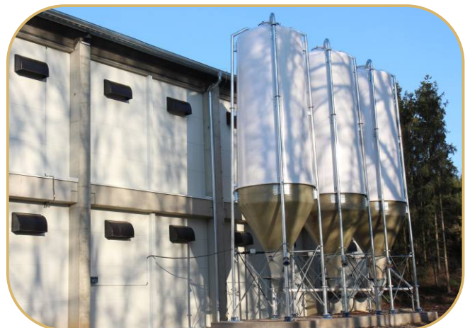
zásobníky krmiva na tenzometrech
