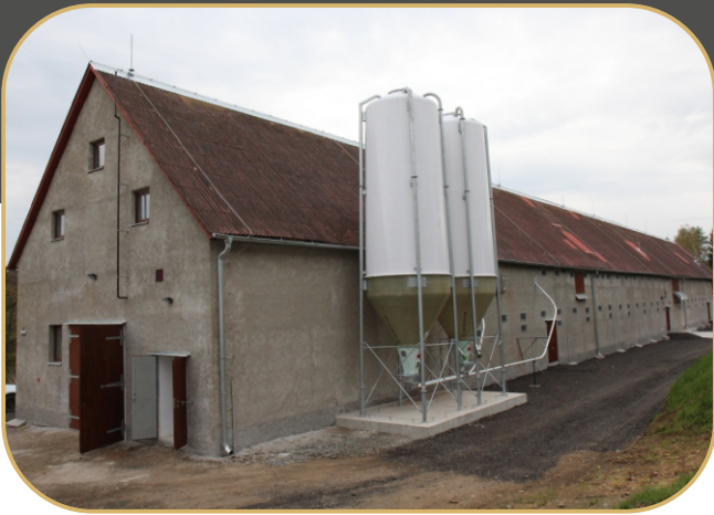
sklolaminátové zásobníky vedle budovy bývalé K120
