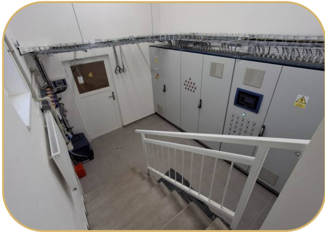
rozvaděče s integrovaným klima a produkčním počítačem
