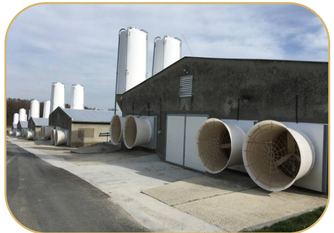
štitové ventilátory a sklolaminátové zásobníky krmiv
