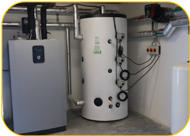
tepelné čerpadlo odebírá teplo z kejdy
