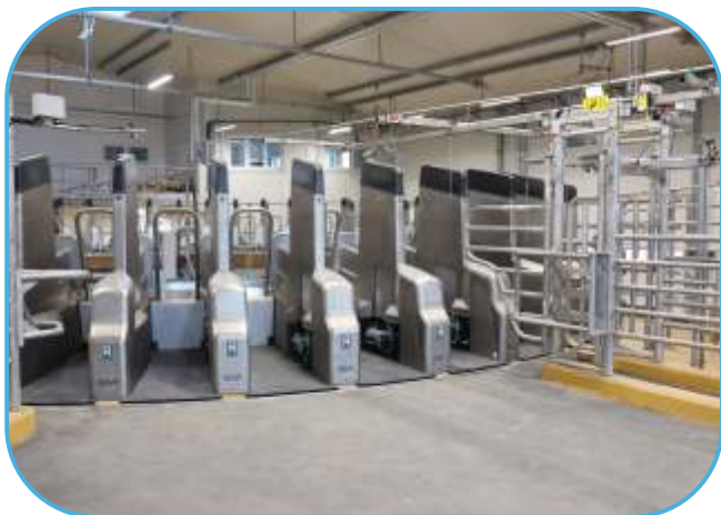
vstup/výstup z dojírny
