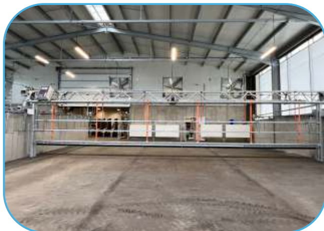
čekárna dojníc s přiháněčem se shrnováním kejdy
