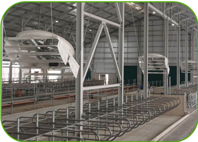
ventilátory s nastavitelnými směrovými žaluziemi
