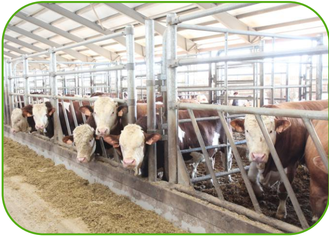
žlabové zábrany diagonální a prosté (3 trubky nad sebou)
