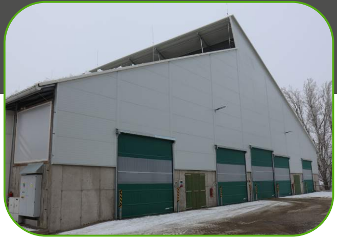
přesah střechy, rolovací vrata
