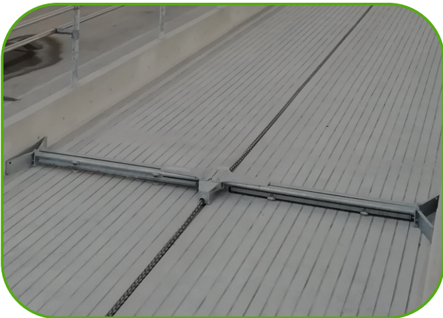
shrnovací řetězová lopata DELTA II
