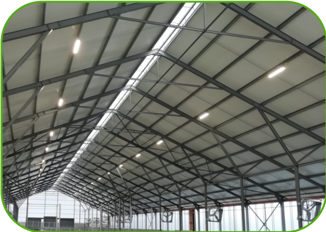
systém ASŘ ovládá osvětlení, ventilátory a boční plachty
