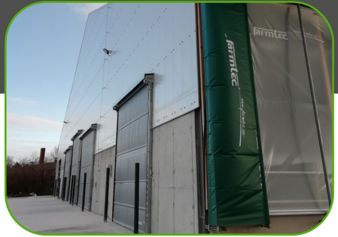
rolovací vrata a boční svinovací plachty
