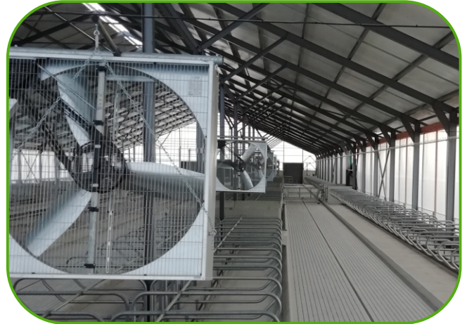
axiální ventilátory nad zastýlanými lehacími boxy
