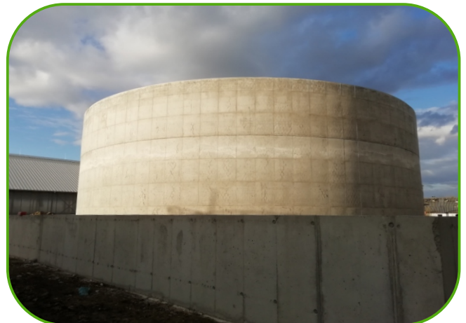
skladovací jímka s míchadly a čerpadly
