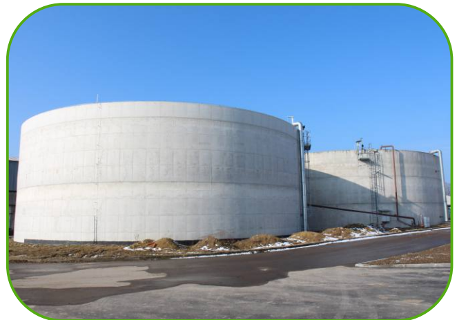
jímky na skladování kejdy
