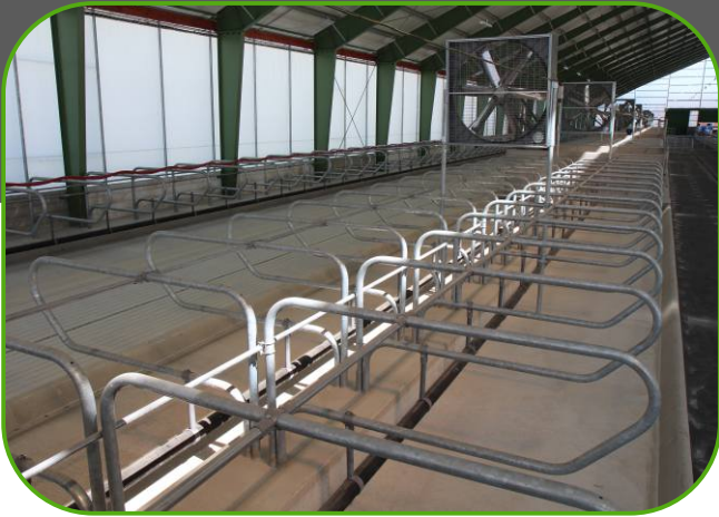
axiální ventilátory nad zastýlanými lehacími boxy
