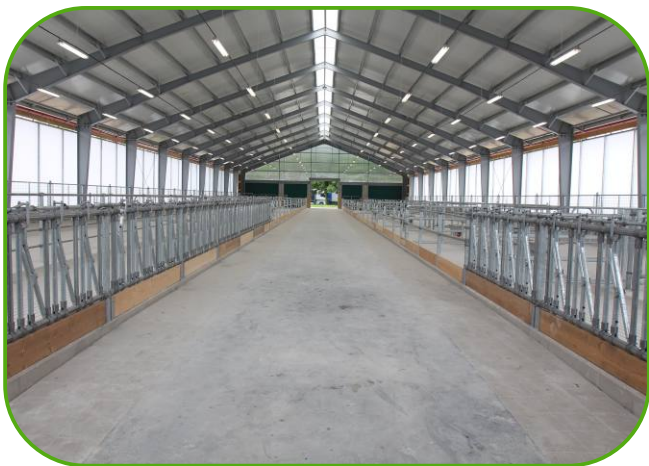
fixační žlabové zábrany
