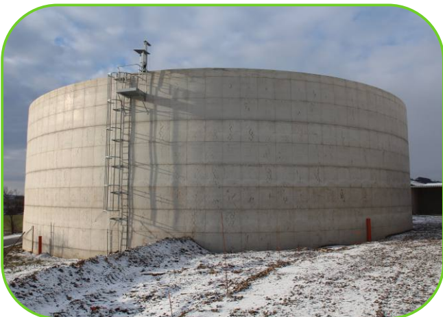
jímka na skladování kejdy
