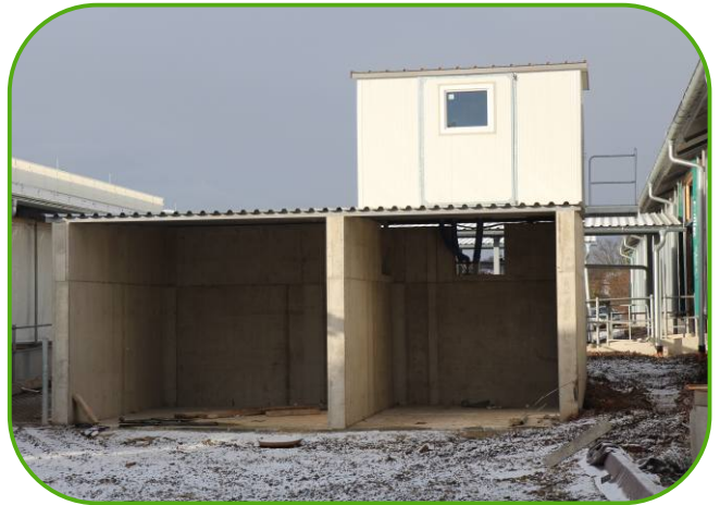
separátor kejdy v izolovaném kontejneru
