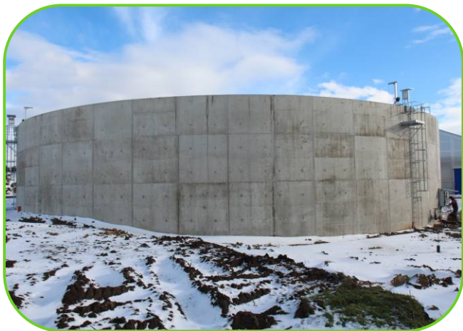
jímka na kejdu s technologií míchání a čerpání
