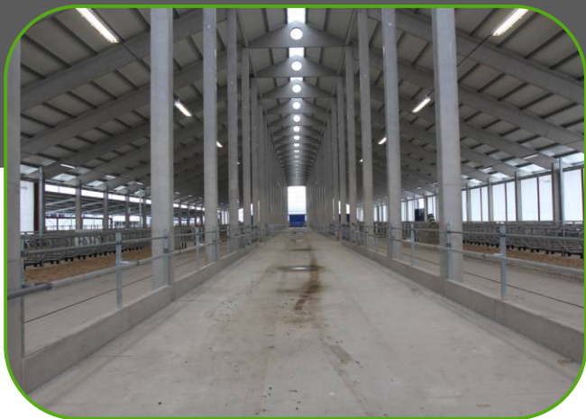
betonová sloupová konstrukce stáje
