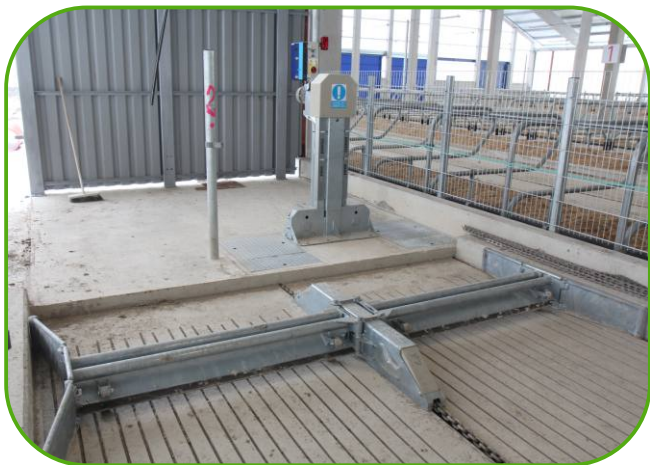
kejdu vyhrnuje řetězový systém DELTA
