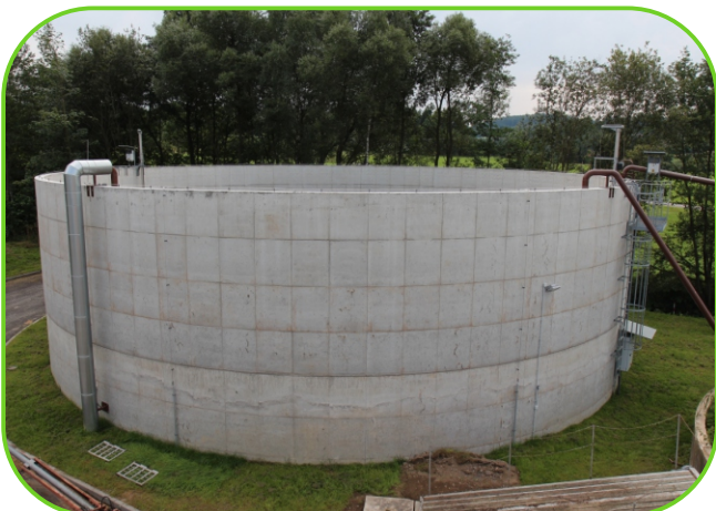
skladovací jímka s míchadly, čerpadlem a výdejním místem
