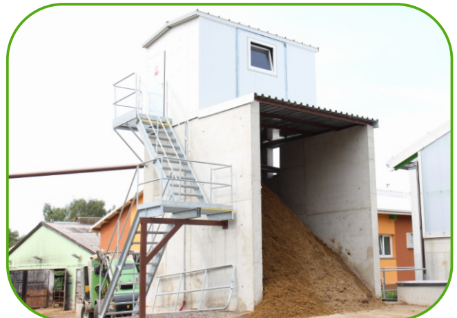
budova se separátorem kejdy a skladovacím prosotrem
