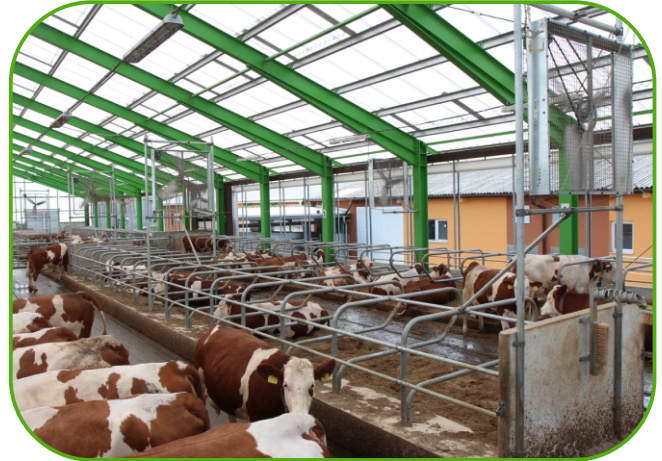
axiální ventilátory nad ležacími boxy
