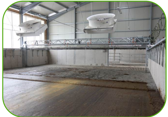
čekárna dojnic s přiháněčem FARMTEC se shrnováním kejdy
