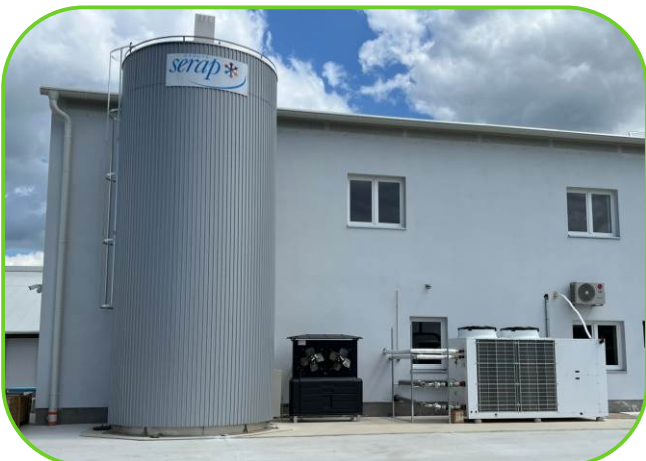
chladičí silo na mléko s kapacitou 40 tis. litrů
