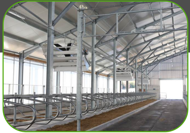
tiché a výkonné ventilátory s nastavitelnými žaluziemi
