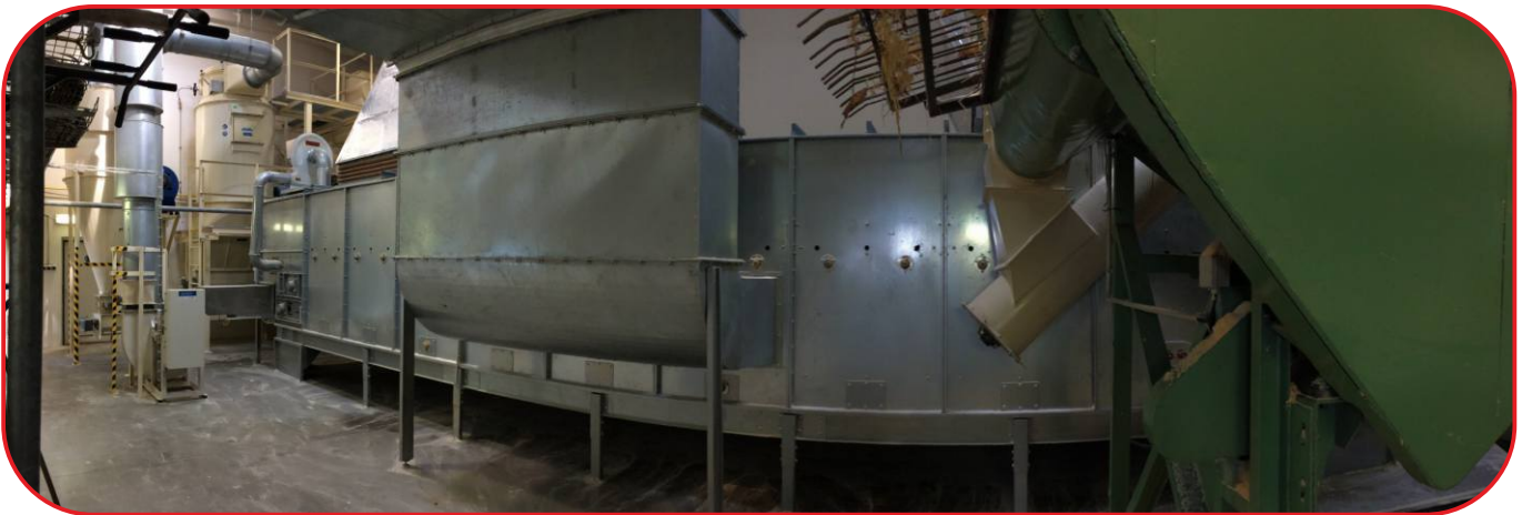
pohled na sušárnu s navazující technologií peletování
