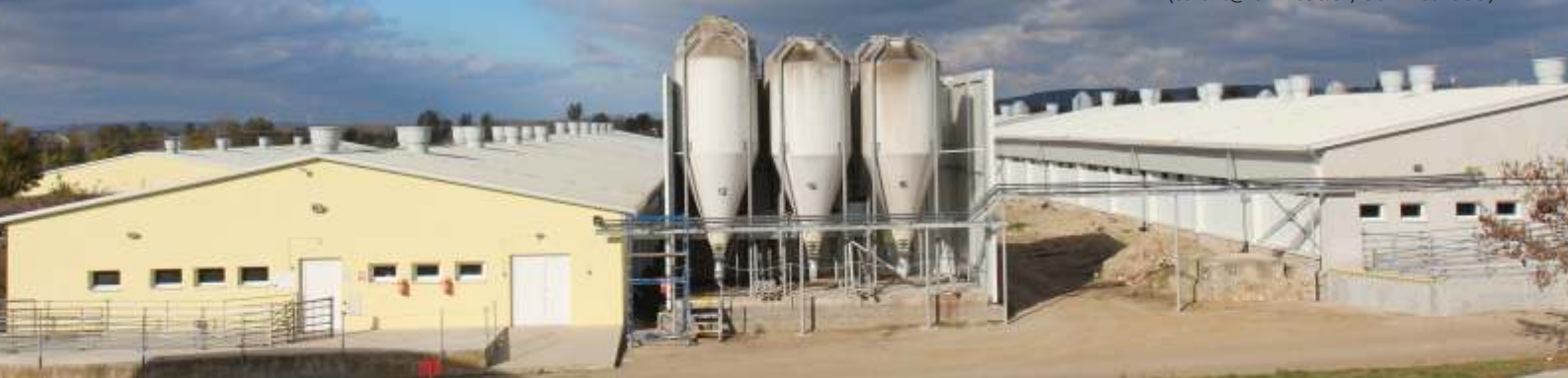
Postupná rekonstrukce hal pro výkrm prasat ve Velkých Němčicích.
