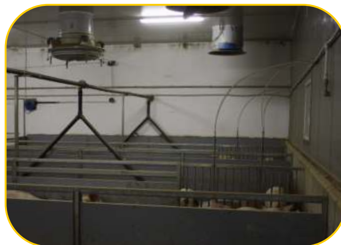
detail komínů (vlevo přívodní, vpravo odtahový)
