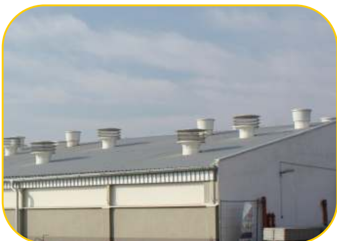
podtlaková ventilace s přívodními a odtahovými komíny
