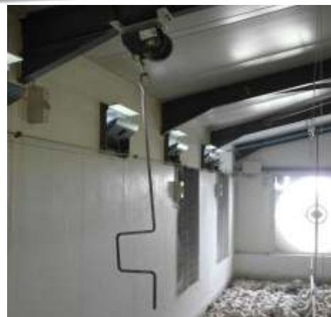
Ovládání výšky zavěšených chladicích jednotek pomocí navijáku.
