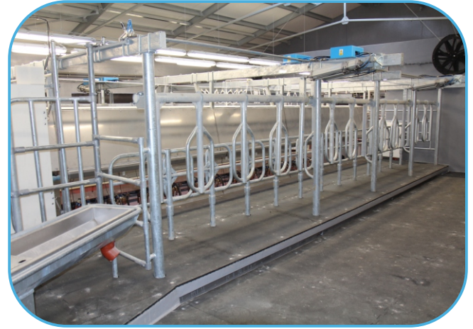
odchod z dojírny s nerezovým napájecím žlabem
