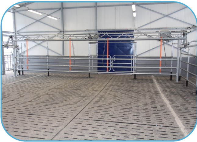
příhaněč v čekárně dojnic
