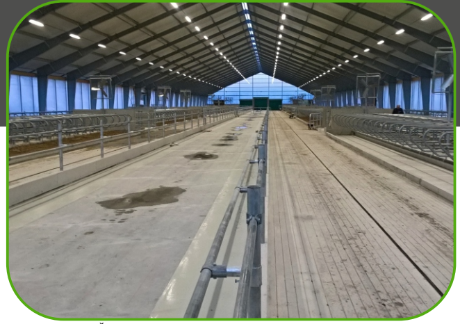
systém ASŘ ovládá LED osvětlení, ventilátory a boční plachty
