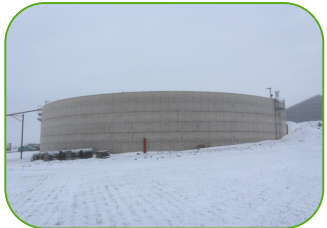
na stáj navazuje skladovací jímka s míchadly a čerpadly
