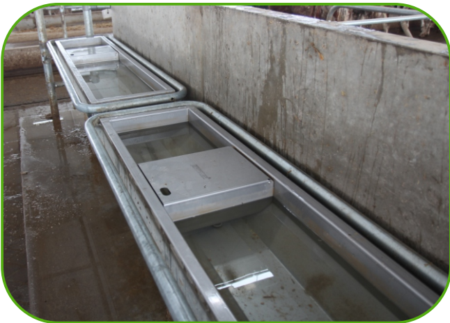
plovákové komory žlabů jsou přístupné bez použití nářadí
