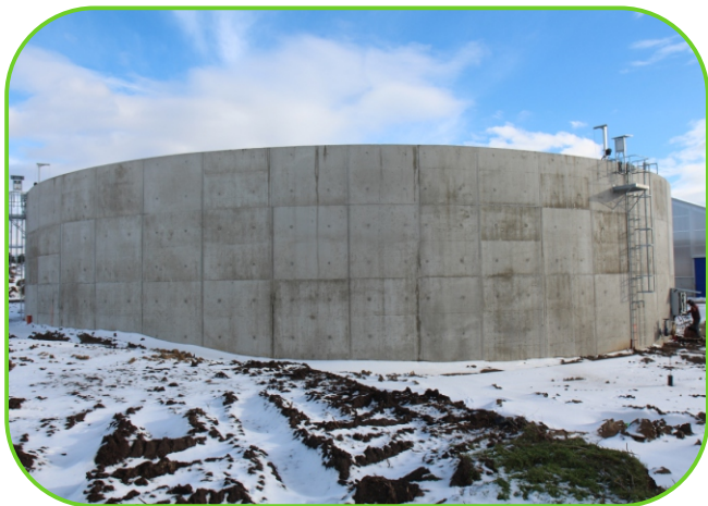
jímka na keжду s technologií míchání a čerpání
