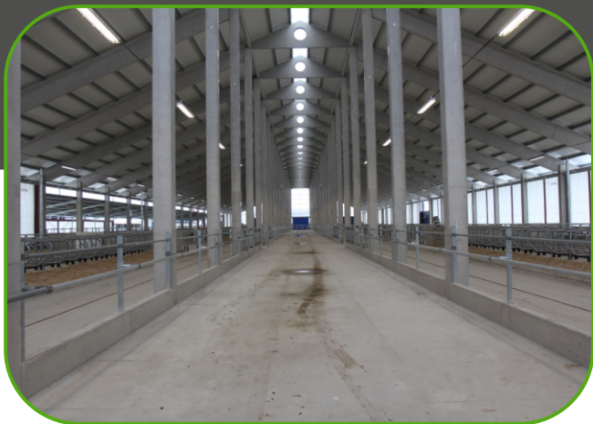
betonová sloupová konstrukce stáje
