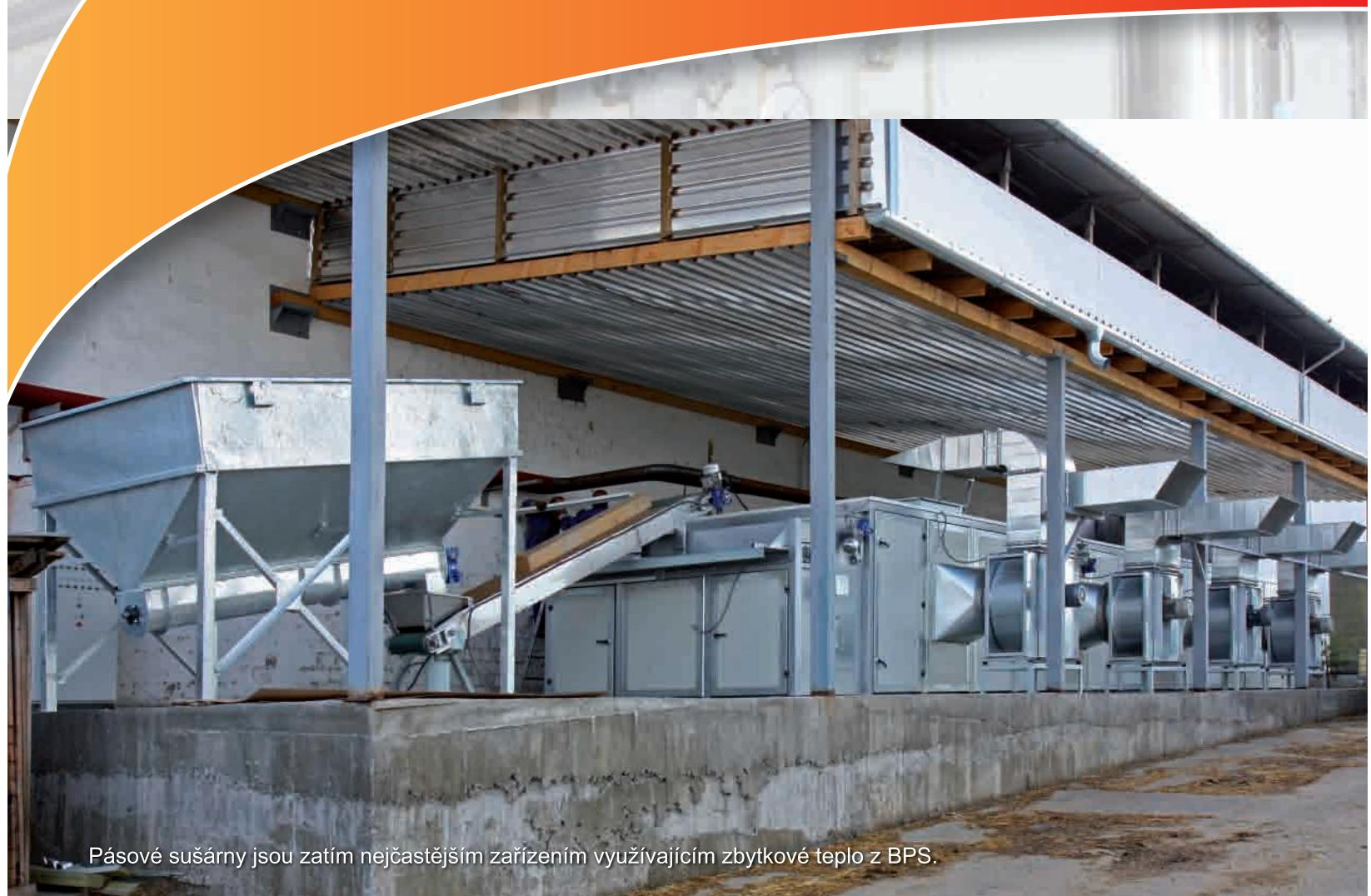
Pásové sušárny jsou zatím nejčastějším zařízením využívajícím zbytkové teplo z BPS.
